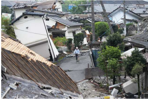
地震で倒壊した家屋（24日、熊本県益城町）、
